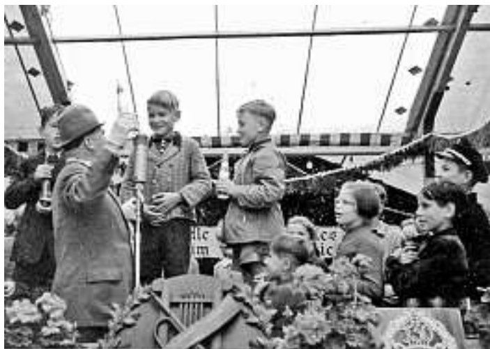
Bild-Nr. 721: Das Foto könnte vom 130jährigen Bestehen der Oberwolfacher Musikkapelle anno 1954 sein? Jedenfalls gab es für die damaligen Zöglinge Werner Echle, Bruno Armbruster und Wolfgang Heitzmann je eine Flasche Limonade zum Geschenk!
