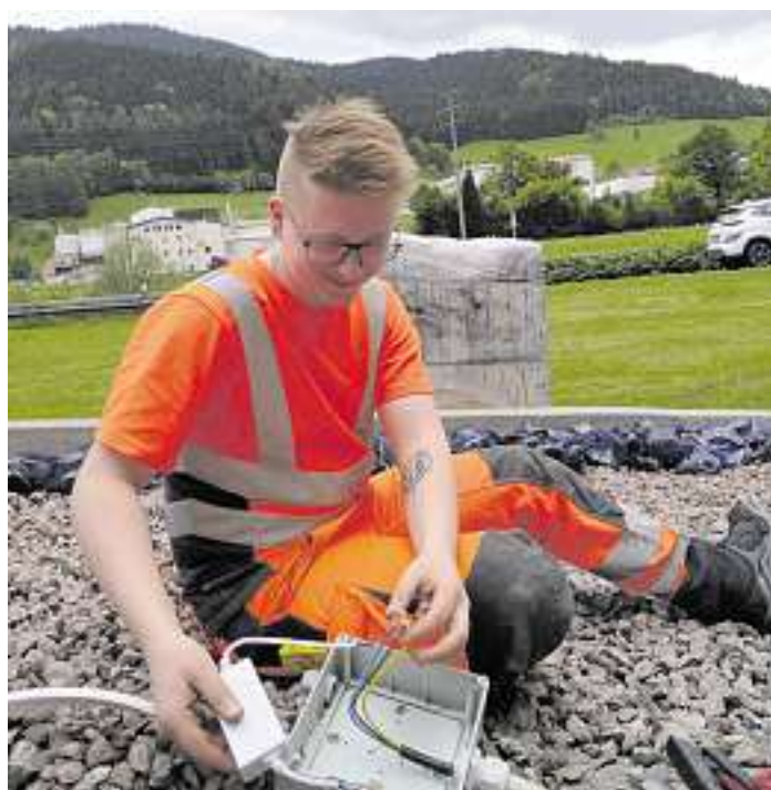
Installation der LED-Beleuchtung
