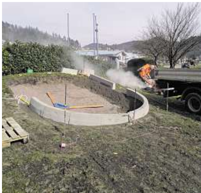
Einfassung der Form mit Granitsteinen
