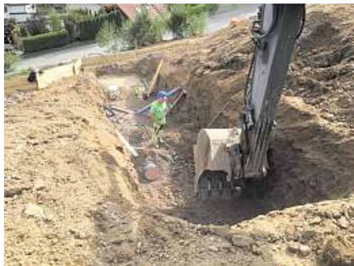
Fa. Bonath beim Verlegen der Versorgungsleitungen im steilen und felsigen Gelände.
