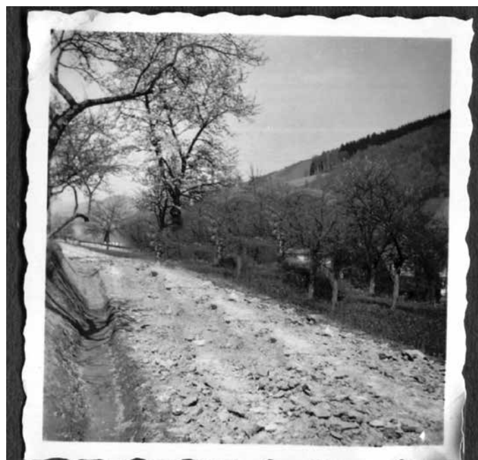
Bild Nr. 740: Foto vom Bau der Friedensstraße oberhalb des Friedhofes um 1950 bis 1960.
